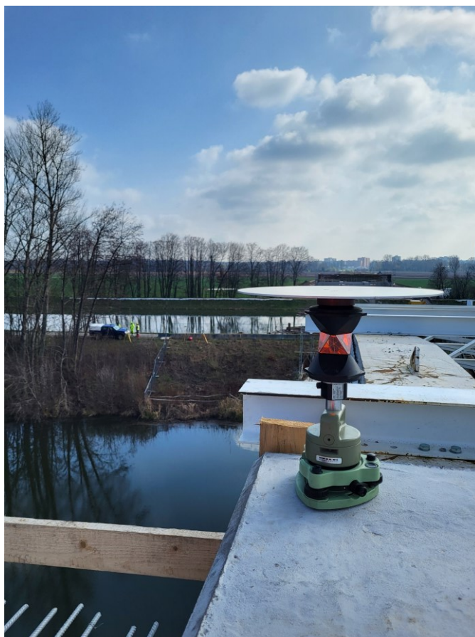
Obr 3 – umístění hranolu na čele vysouvané konstrukce
